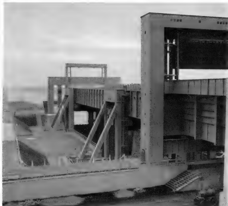
Le chaland est en place dans l'ascenseur.
